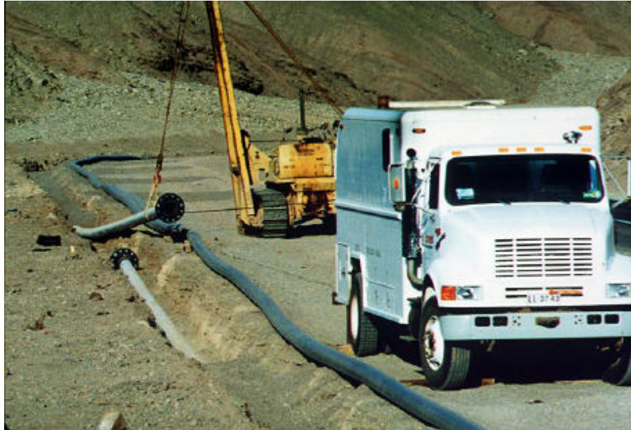
Procedimiento de “ Pulling” o Inserción del “ Liner” de HDPE
